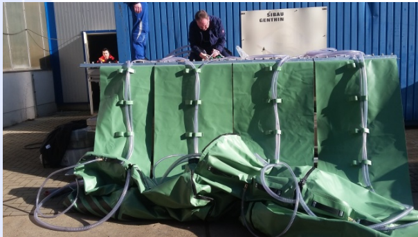
Montage der Ventile Verschraubungen, Schläuche und Absperrhähnen
