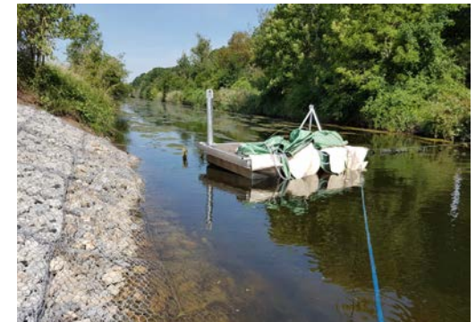
Montierter Ponton und Buhne
