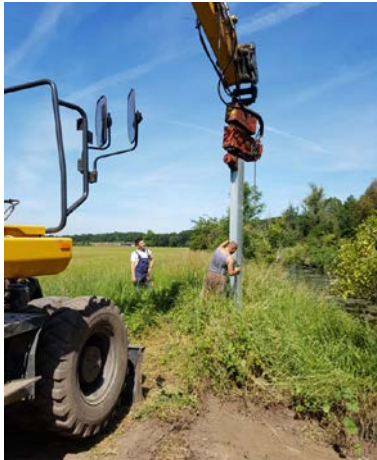
Rammen der Uferpfähle
