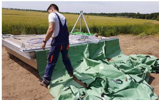
Montage der Schlauchbuhnen
