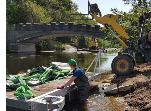
Einbringung der Pontons ins Gewässer
