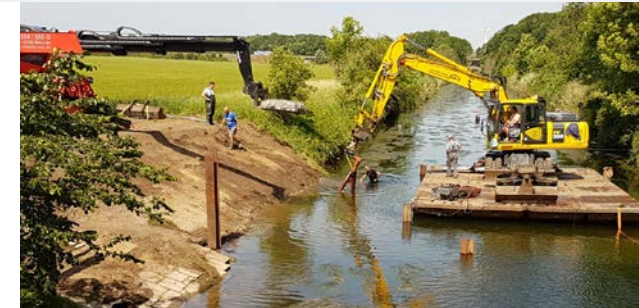
Verlegung mit Bagger und Teleskopstapler
